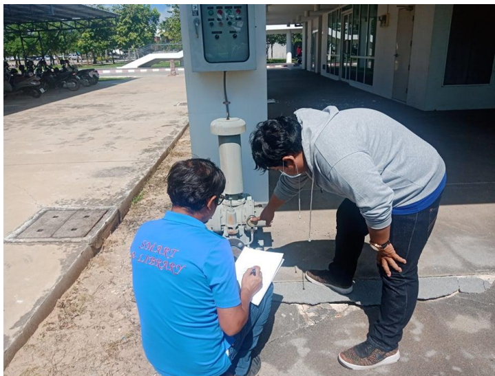
ภาพการตรวจสอบระบบบำบัดน้ำเสีย
