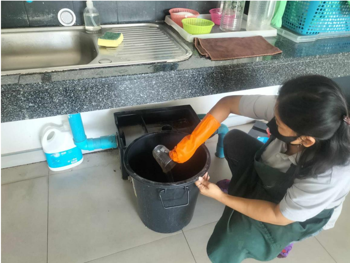
ภาพการตัดทำความสะอาดถังดักไขมัน
