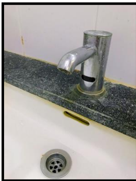
ก๊อกน้ำอัตโนมัติ/ก๊อกน้ำเซ็นเซอร์ เปิดปิดอัตโนมัติโดยไม่ต้องสัมผัส
