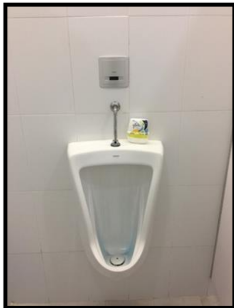
สุขภัณฑ์ประหยัดน้ำ ภายในห้องน้ำชาย และห้องน้ำหญิง
