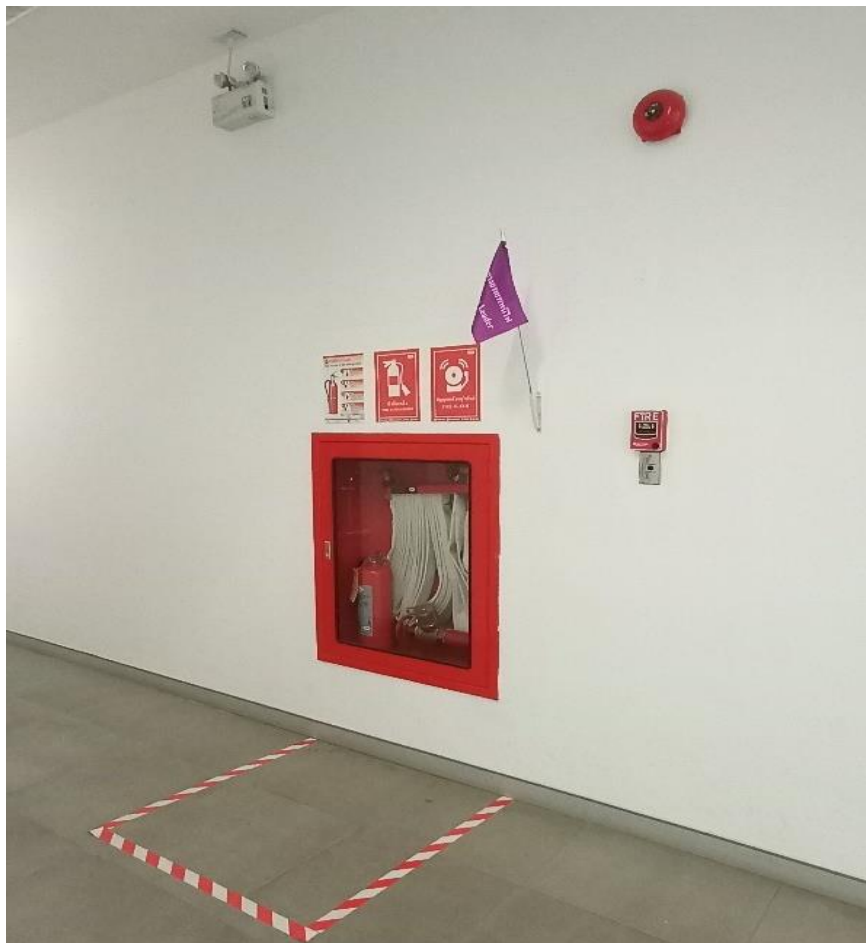
บริเวณ ชั้น 3 โซน A
