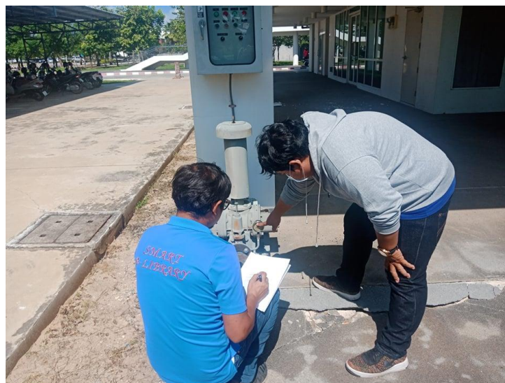
ภาพการตรวจสอบระบบบำบัดน้ำเสีย
