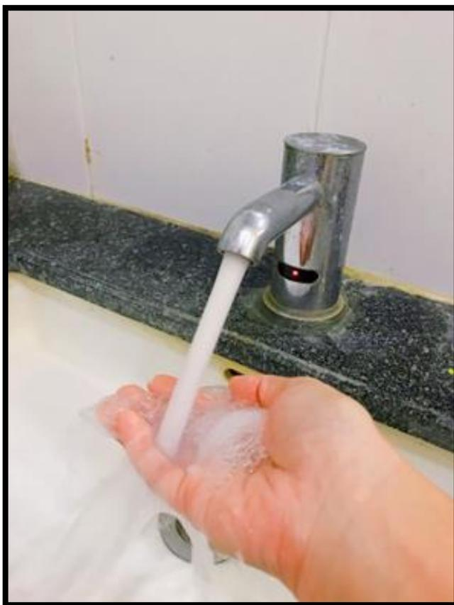
เมื่อยื่นมือในระยะตรวจจับของเซ็นเซอร์ น้ำจะไหลออกจากก๊อกและน้ำจะหยุดไหลภายใน 0.5-2 วินาที
