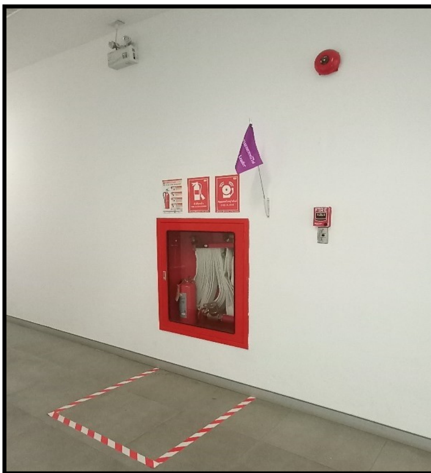
บริเวณ ชั้น 3 โซน A
