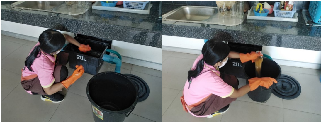
ภาพการทำความสะอาดถังดักไขมัน
