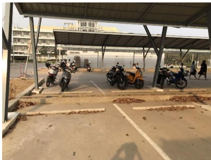
ภาพถ่ายที่จุดตรวจภายนอกอาคารเพื่อลดการเกิดควันไปเสียรถยนต์
