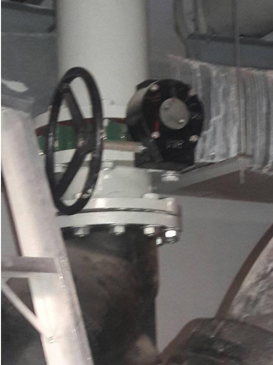
ภาพถ่ายการซ่อมบำรุงรักษาเครื่องปรับอากาศ
