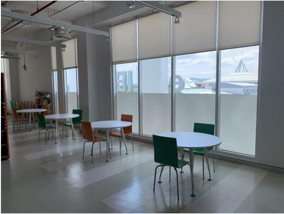
ภาพที่ 11 ใช้มู่ลี่กันสาดบังแสงแดดส่องเข้ามาภายในตัวอาคารเพื่อลดความร้อน และประหยัดพลังงานไฟฟ้า
