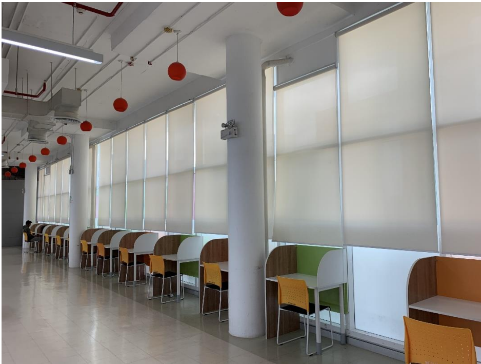
ภาพที่ 12 ใช้มู่ลี่กันสาดบังแสงแดดส่องเข้ามาภายในตัวอาคารเพื่อลดความร้อน ทางทิศตะวันตกของตัวอาคารในการประหยัดพลังงานไฟฟ้า
