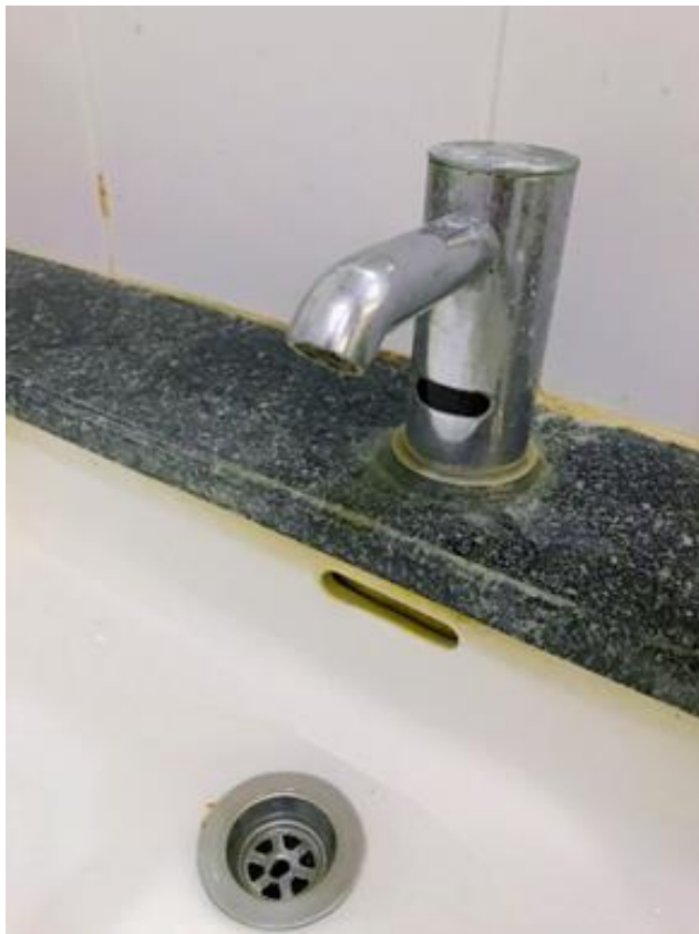
ภาพที่ 12 ก๊อกน้ำอัตโนมัติ/ก๊อกน้ำเซ็นเซอร์ เปิดปิดอัตโนมัติโดยไม่ต้องสัมผัส
