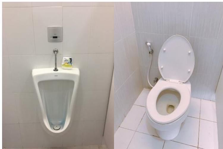
ภาพที่ 11 สุขภัณฑ์ประหยัดน้ำ ภายในห้องน้ำชาย - หญิง
