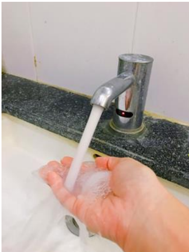
ภาพที่ 13 เมื่อยื่นมือในระยะตรวจจับของเซ็นเซอร์ น้ำจะไหลออกจากก๊อก และน้ำจะหยุดไหลภายใน 0.5-2 วินาที หลังจากนำมือออก
