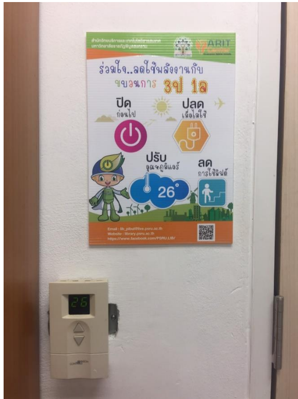
ภาพที่ 1 ตั้งอุณหภูมิเครื่องปรับอากาศที่ 26 องศาเซลเซียส
